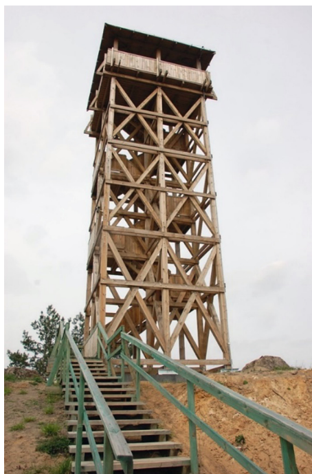
Fot. 10. Wieża widokowa na Osowej Górze – 2013 r. (fot. M. Cichoń)
